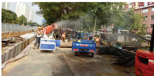
七公司前十街排水方涵、电力隧道工程喷雾炮降尘
