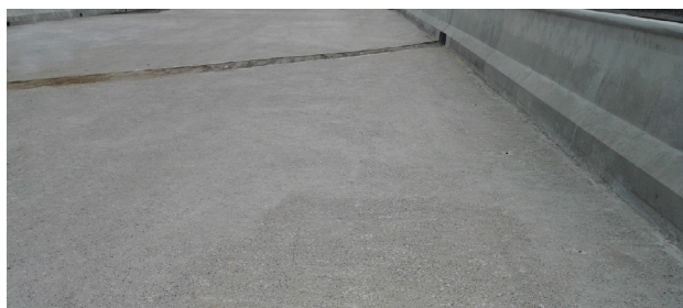
七公司临港涛坪线绣针河桥桥面凿毛均匀
