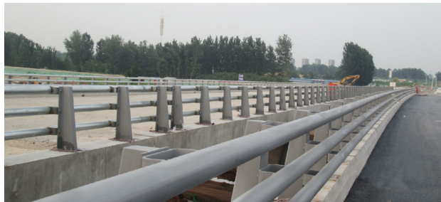
一公司西安路沭河桥栏杆安装直顺
