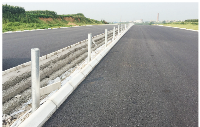
北斗公司:S341 涛坪线路缘石施工好
