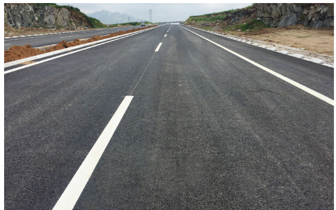
北斗公司:S341 涛坪线标线施工好
