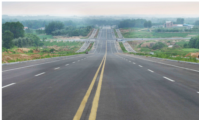
全文明工地称号。6月5日，污水厂西路通车；8月7日，黄海九路通车。二公司 王祥宇
